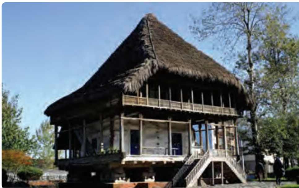
شکل ۷-۲- خانه‌ای با سقف گالی پوش
