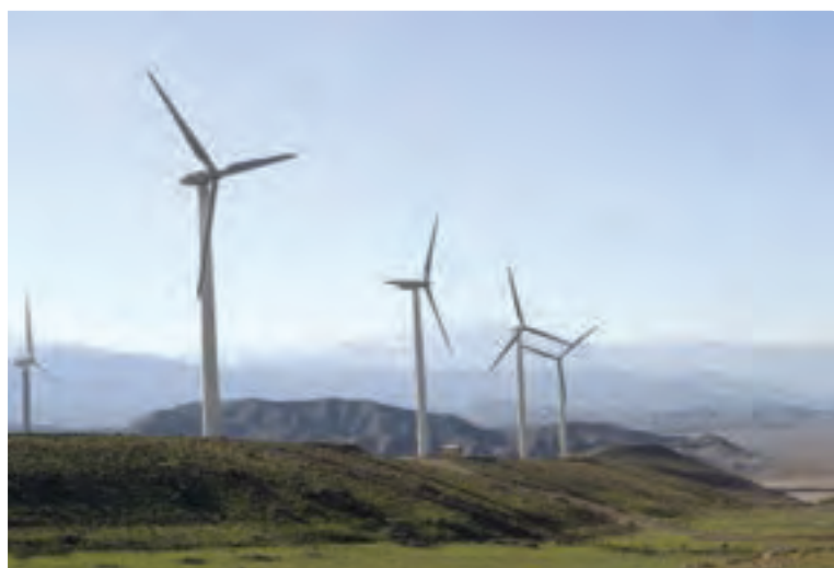
شکل ۲۷-۵- نیروگاه برق بادی منجیل
